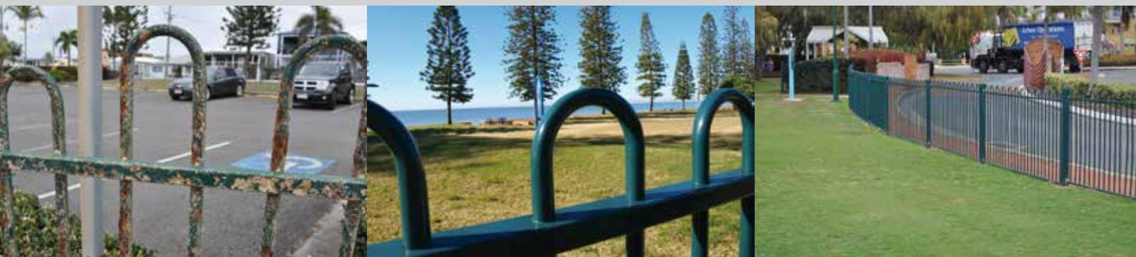
En 1996 una empresa local de recubrimientos de Brisbane recomendó Plascoat® PPA 571 en una licitación para retirar, chorrear con arena, volver a revestir y reinstalar vallas en Sutton Beach, uno de los parques costeros de Brisbane. Mientras que la tecnología de recubrimiento elegida anteriormente tardó solo 6 meses en corroerse completamente, las vallas recubiertas con Plascoat® PPA 571 siguen pareciendo hoy en día como nuevas.
